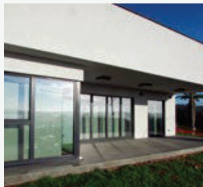
Dom pasywny w Miño Dom w technologii budownictwa pasywnego Miño, Hiszpania Aquarea
