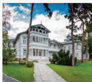
Pensjonat i spa Gurewicz Hotel – restauracja – spa Otwock, Polska PACi, VRF i Control
