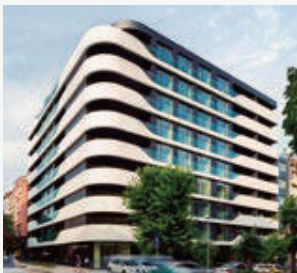
Budynek Varna Wave Obiekt mieszkalny Warna, Bułgaria Aquarea i Aquarea Smart Cloud
